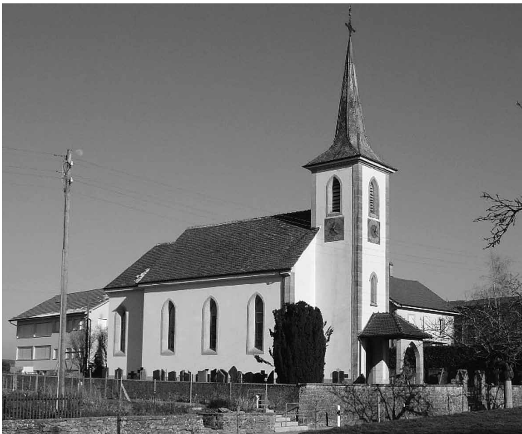
L'église de Seiry, dédiée à saint Georges.
